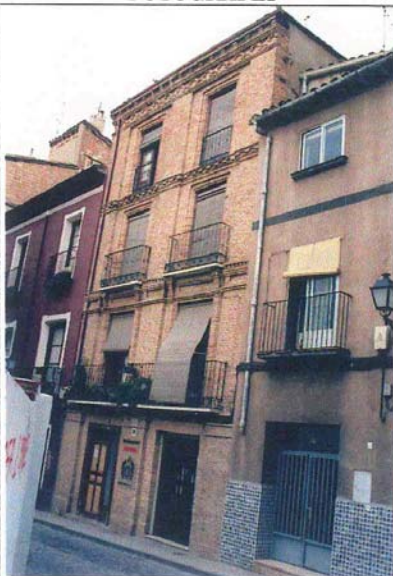
Fachada hacia la calle Ramiro el Monje
