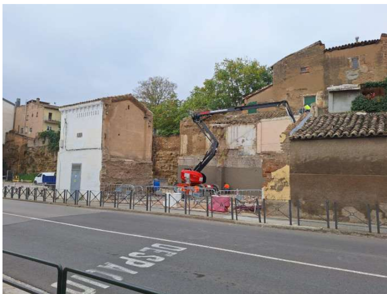
Obras de derribo de edificio en ronda Montearagón
