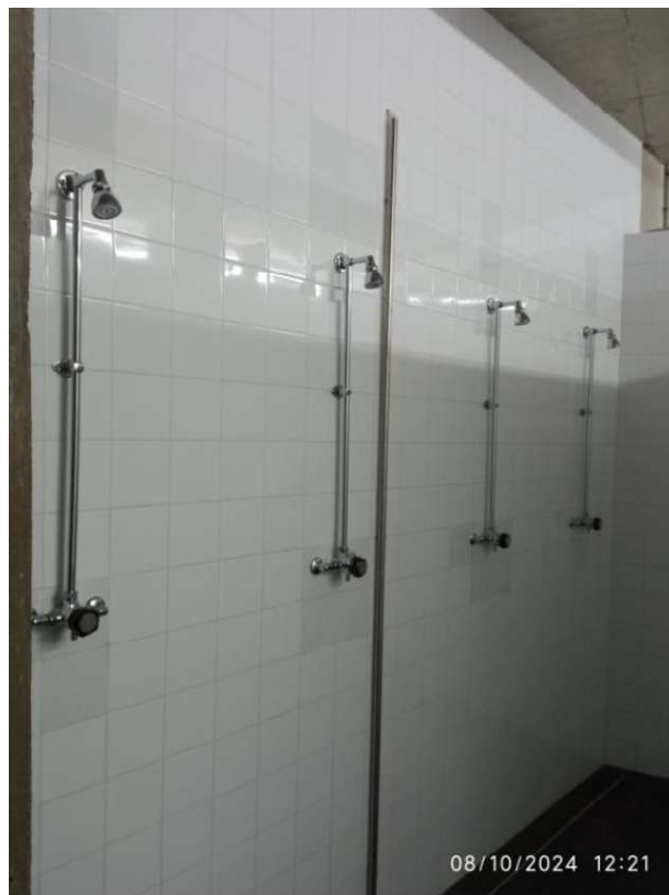
Vestuarios (duchas) estado final
