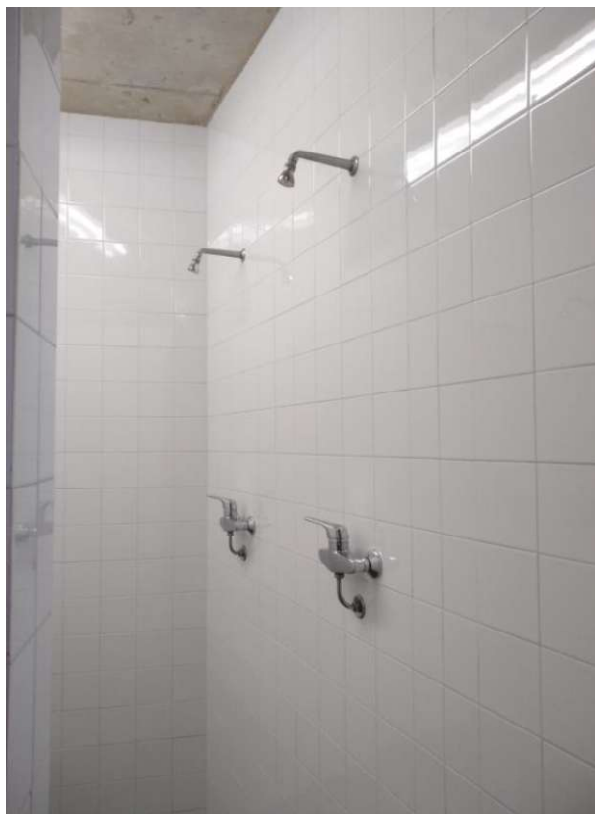
Vestuarios (duchas) estado inicial
