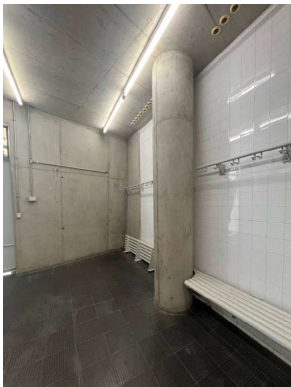
Vestuarios estado inicial
