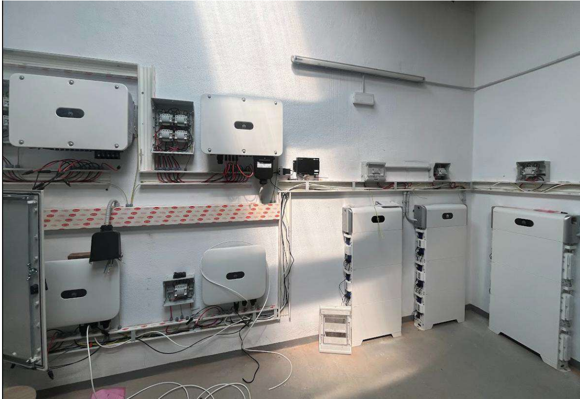
Instalación de inversores (40 + 40 + 10 + 10) y grupos de baterías de almacenamiento.
