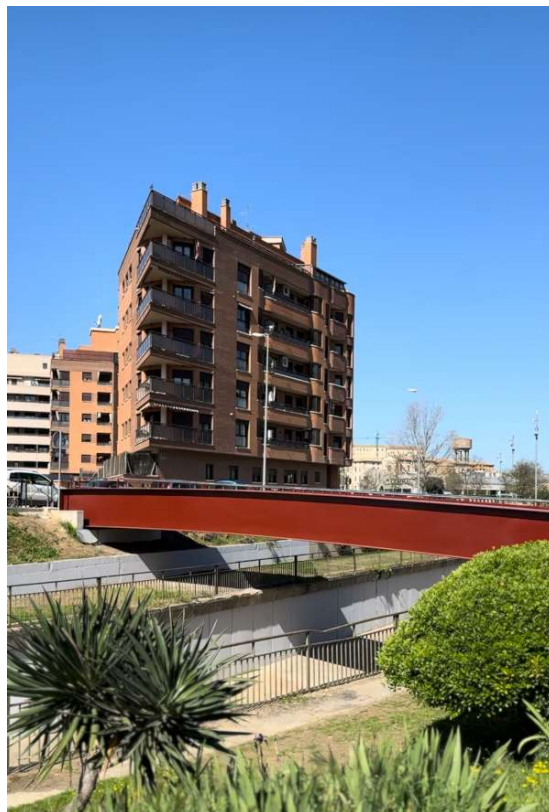
Estado tras la intervención
